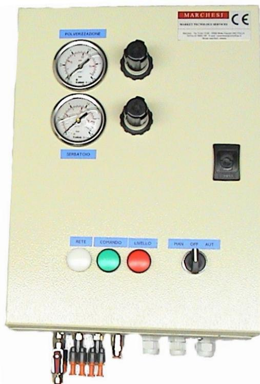
Impianto automatico di lubrificazione a spruzzo in grado di alimentare sino a 4 valvole contemporaneamente.
